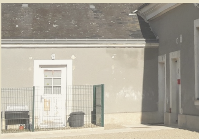
Avrillé-les-Ponceaux _ géothermie du groupe scolaire
