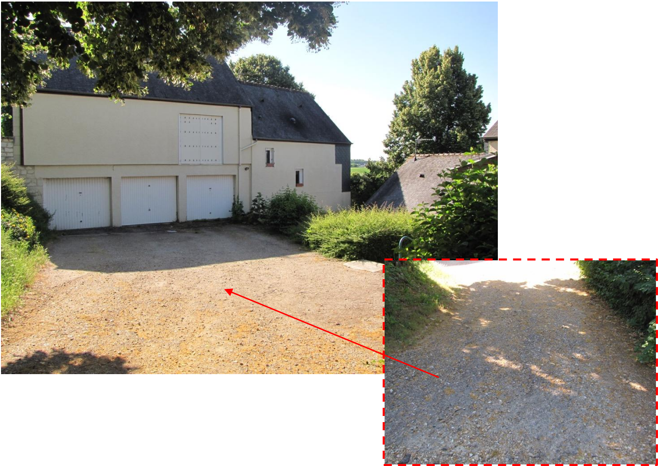
Figure 42 : Revêtement perméable du lotissement Kroll
