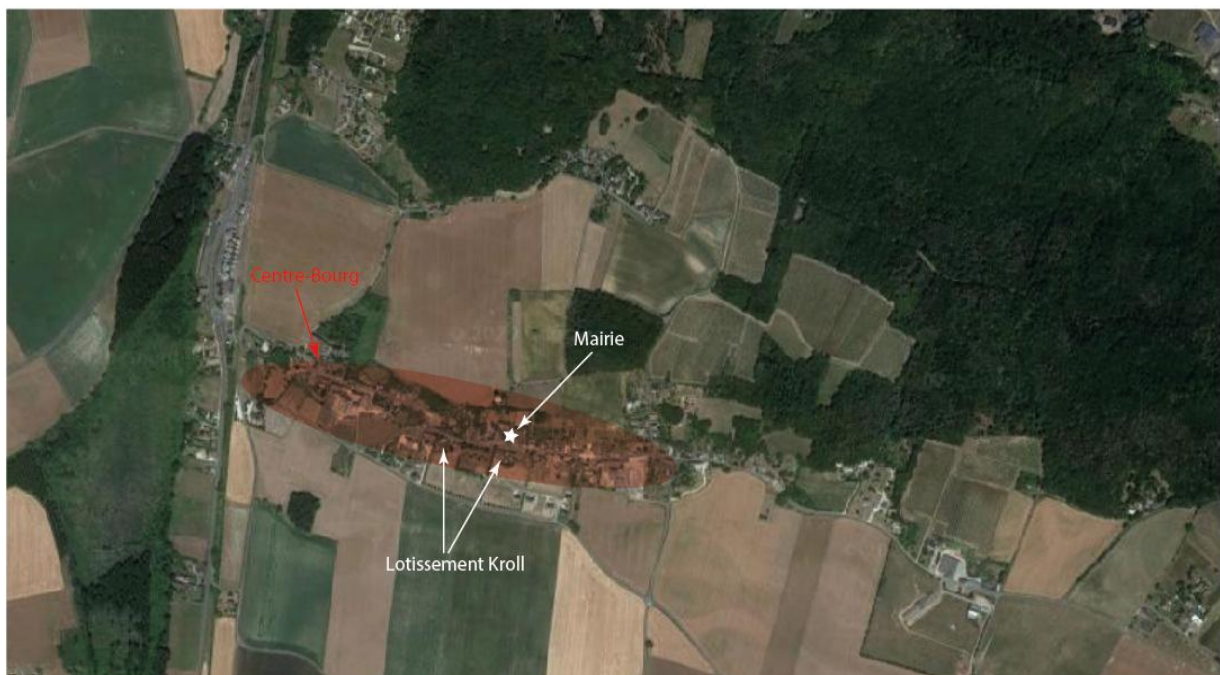
Figure 24 : Photo aérienne, situation du lotissement Kroll
