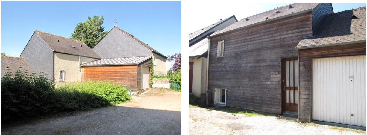
Figure 47 : Le bois, matériau de prédilection pour Lucien Kroll
