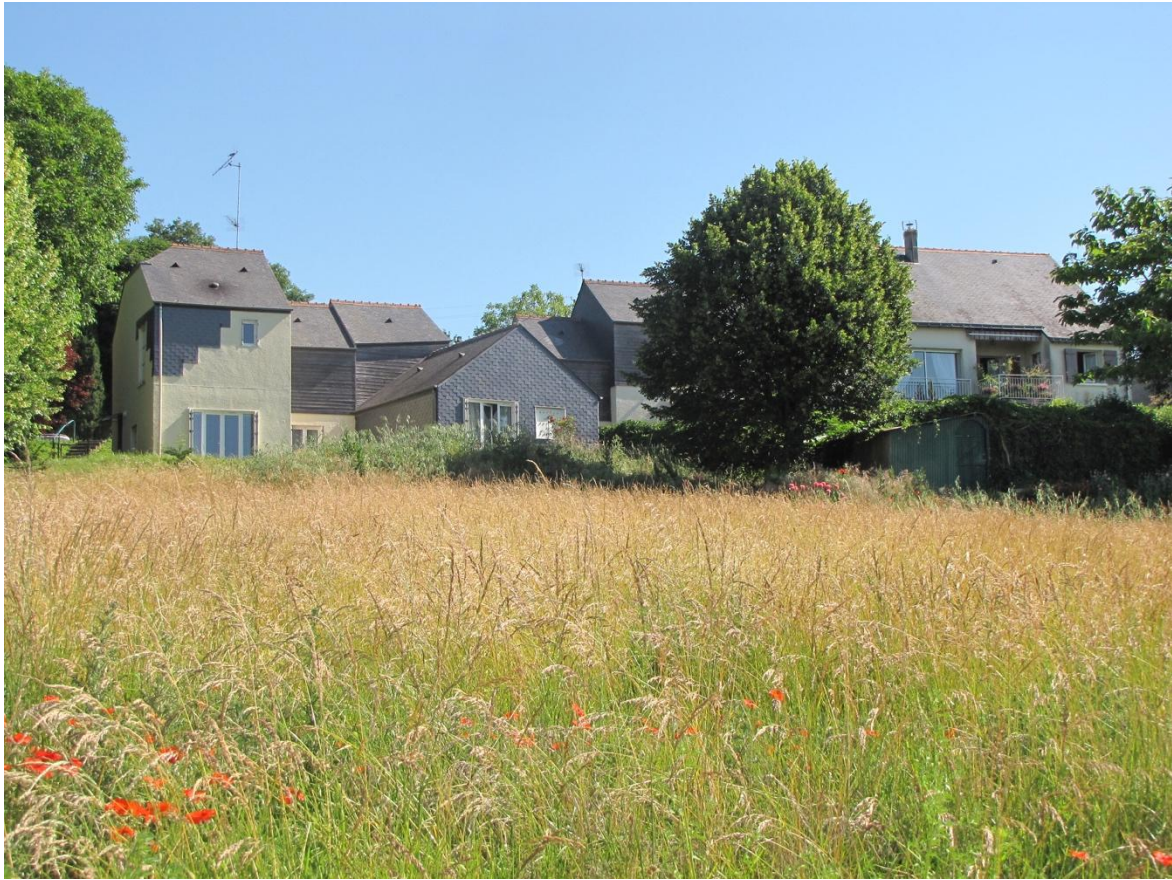
Figure 27 : Îlot 2 du lotissement Kroll, pris en contrebas du coteau.
