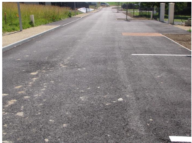
Figure 58 : Revêtement imperméable lotissement La Roche Claire
