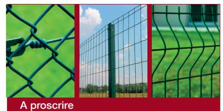
Si le mur de clôture est surmonté d'une grille, celle-ci sera de facture simple : barreaux verticaux soudés sur des traverses hautes et basses. L'ajout de volutes sur la lisse supérieure est à proscrire afin d'éviter tout maniérisme incompatible avec l'esprit du site.
