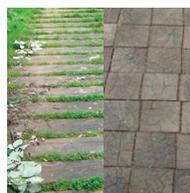
**Le bois** sous forme de traverses ou de pavés jointoyés au mortier de chaux ou avec des granulats de teinte sombre ou encore, enherbés. Les traverses de bois peuvent également servir à la réalisation d'emmarchement.
