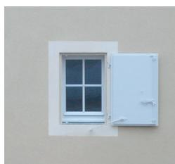
Les **baies** reprendront, ou se rapprocheront, du rapport hauteur/largeur :  $h = 1,65 \text{ à } 1,75 \times l$ , avec  $l$  minimum 0,65 m et  $l$  maximum 1,11 m.
