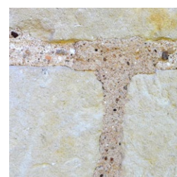
Les conséquences de l'usage de mortier au ciment qui bloque les échanges gazeux dans la maçonnerie ancienne : la pierre de calcaire tendre (tuffeau) se désagrège.
