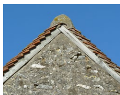
Traitement des rives sur le bâti traditionnel
