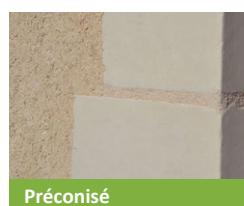
Enduit à pierre vue. L'enduit affleure les pierres de taille
