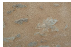
Enduit à pierre vue
