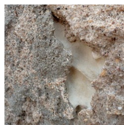
Les conséquences de l'usage de mortier au ciment qui bloque les échanges gazeux dans la maçonnerie ancienne : la pierre de calcaire tendre (tuffeau) se désagrège.
