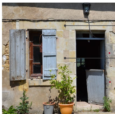
Bloc «porte-fenêtre» à jambage commun, caractéristique du logis rural
