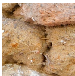
Mortier de terre - détail : terre, gravillons et paille
