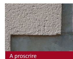
Enduit à pierre vue. L'enduit affleure les pierres de taille
