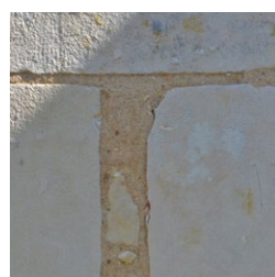
Jointoiement de pierres appareillées
