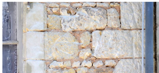
Maçonnerie de moellons calcaires soigneusement assisés
