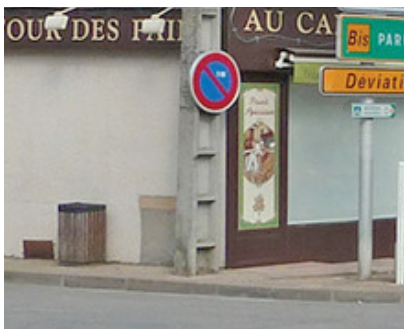
Etroitesse des trottoirs - obstacles
