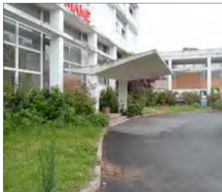
Site MAVE à Tours, Bernard Zérfuss et Jean Prouvé architectes
