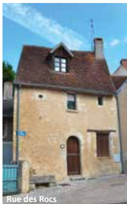
Rue des Rocs
