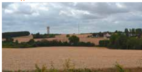
Château d'eau aux environs du Breuil
