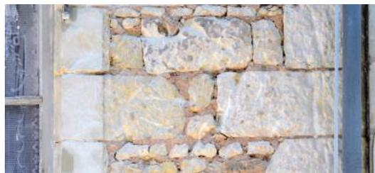
Maçonnerie de moellons calcaires soigneusement assisés (Maison de bourg du Grand-Pressigny)
