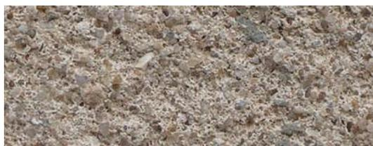
La  **finition lissée** est réalisée sur un enduit frais après talochage par passage du dos de la truelle. Le grain est alors enfoncé dans l'épaisseur de l'enduit.
