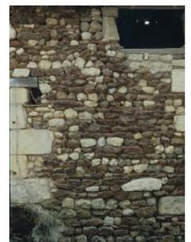
Maçonnerie de silex et de moellons calcaires (Courvaux)
