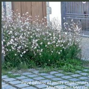
*"Pavés bétonnés et joints engazonnés, Moellan-sur-Mer (56)*
