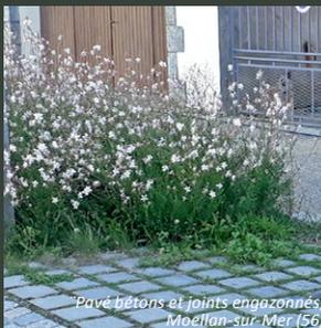
*Pavé bétons et joints engazonnés, Moellon-sur-Mer (56)*
